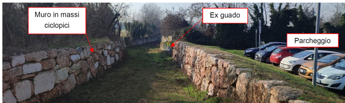
- Argini in corrispondenza del parceggio di via della Consortia -
