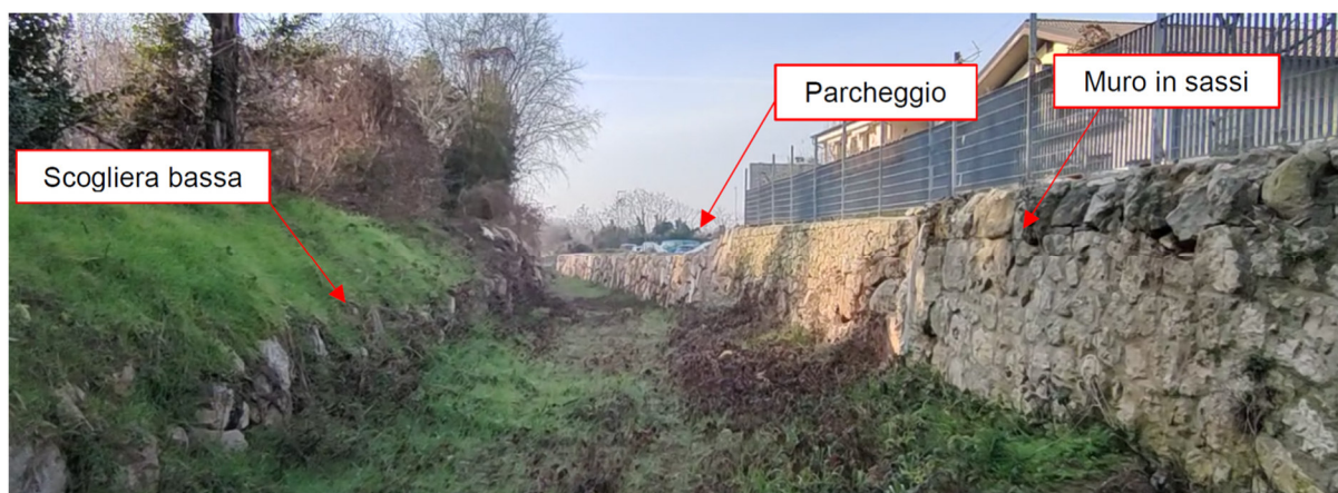
- Argini a monte del parceggio di via della Consortia -
